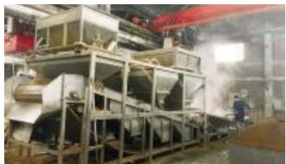
工人在新设备旁操作
